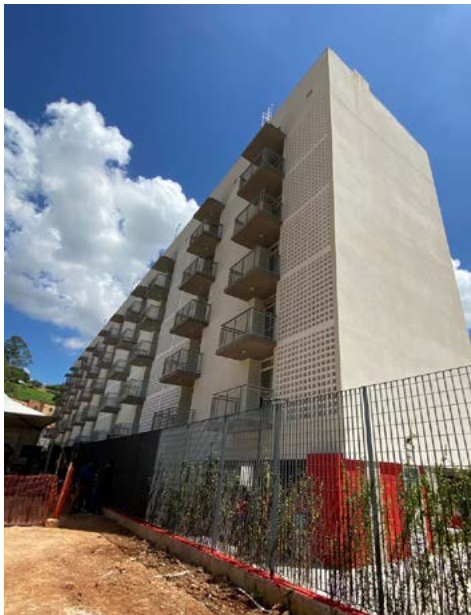
Conjunto Habitacional Bamburrall (Blocos A, D e E)
