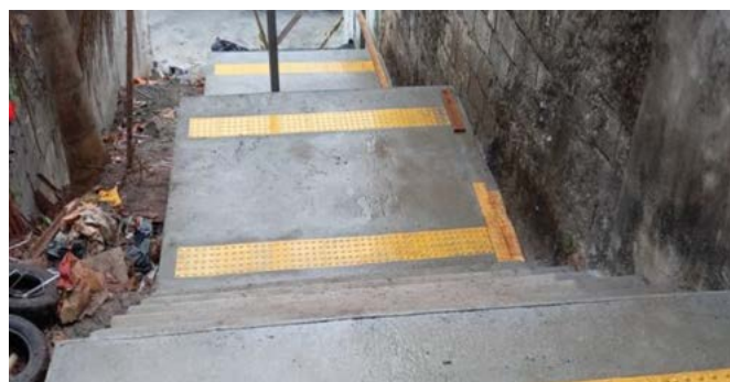
Construção de escadão em via na Rua José Francisco, 403
