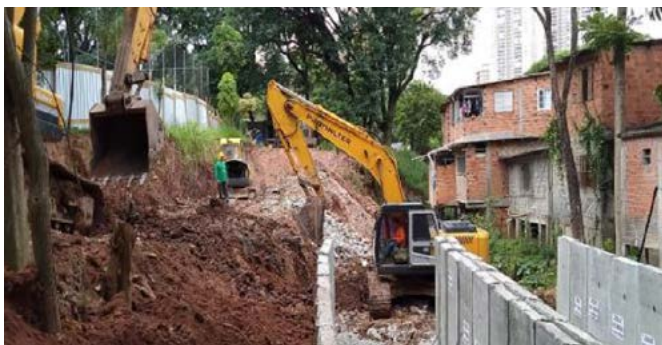
Obra de Emergência - Recuperação da Margem do Córrego Itararé
