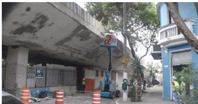
Obras de recuperação e reforço de Obras de Arte Especiais
